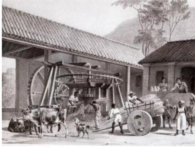
Fig.9 - Moinho mecânico de cana-de-açúcar
